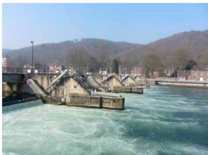
Barrage à vannes automatisés de La Plante
