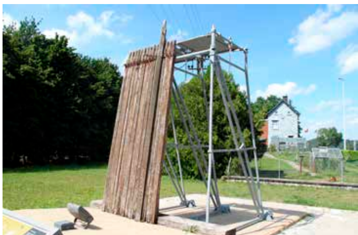
Anciens éléments d'un barrage à aiguilles exposé à l'écluse d'Hastière. Les éclusiers régulaient le débit en ajoutant/enlevant manuellement les aiguilles de bois
