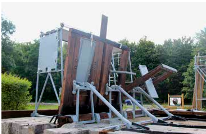
Anciens éléments d'un barrage à hausse exposé à l'écluse d'Hastière. Les éclusiers régulaient le débit en manipulant manuellement les hausses.
