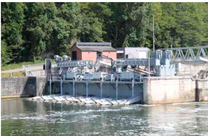
Centrale hydroélectrique installée à l'écluse d'Hastière en 2016
