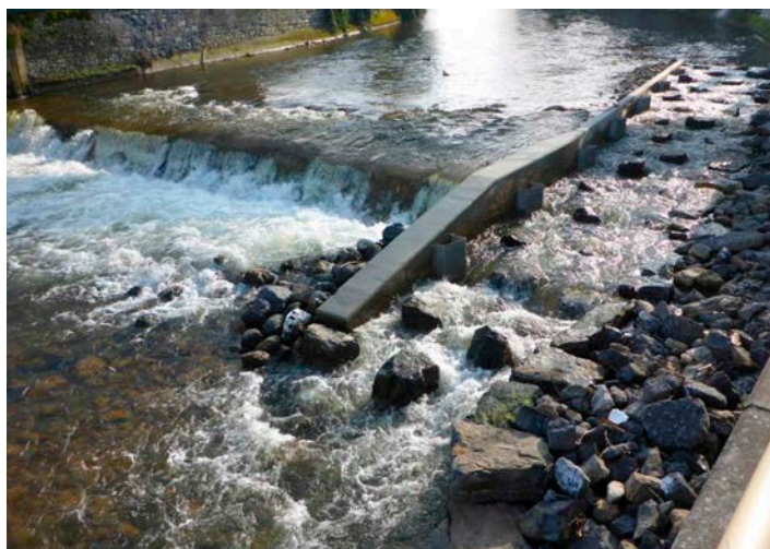
Rampe rugueuse réalisée sur l'Eau Noire par le SPW en 2015 pour contourner un barrage dans le centre de Couvin. Six autres obstacles à la libre circulation des poissons ont été levés par le gestionnaire régional sur la partie aval du cours d'eau jusqu'à sa confluence avec le Viroin
