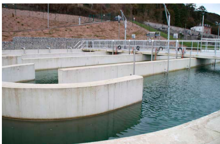
Bassin d'aération de la station d'épuration de Dinant
