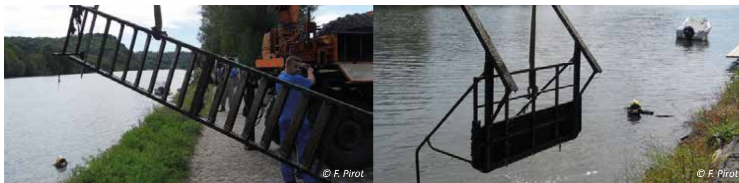
Enlèvement d'embarcadères abandonnés (Direction des Voies hydrauliques de Namur, 26 mai 2014)
