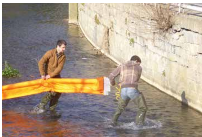
Ancrage du barrage sur le Samson à Andenne
