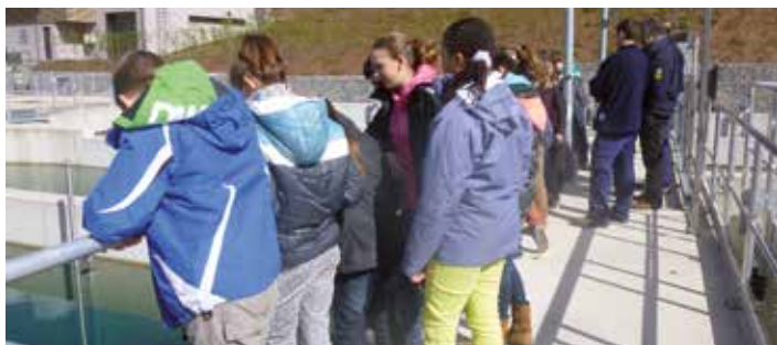
L'Inasep a ouvert plusieurs stations d'épuration pour le grand public et les écoles, dont celle de Dinant entrée en fonction en début d'année
