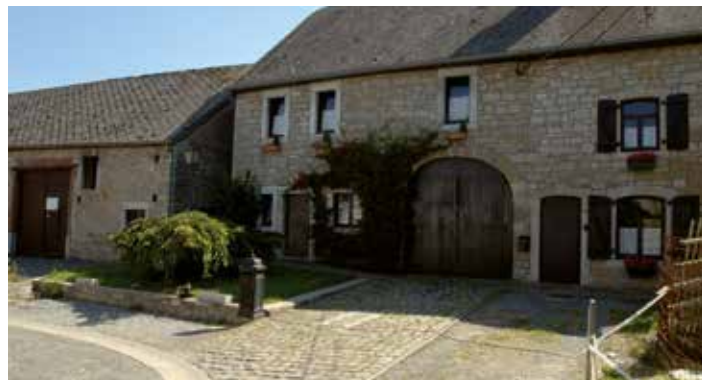
Exemple de surface imperméable reliée à une voirie équipée d'un filet d'eau qui ne pourra plus être traitée à l'herbicide par le particulier dès le 1 er septembre 2014 (© SPW)
