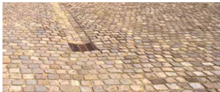
La première solution alternative pour éviter que « les mauvaises herbes » s'implantent sur vos surfaces imperméables (pavés, klinkers, tarmac...) consiste à procéder à un balayage régulier pour empêcher la matière organique (qui permet aux graines de germer) de s'y accumuler (© SPW)
