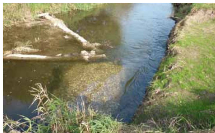
Deux troncs forment un déflecteur dirigeant le courant sur un banc de galet à Mariembourg (Eau Blanche)
