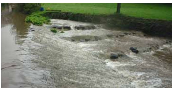
Pré-barrages pour décomposer une chute importante en autant de petites chutes franchissables de 23 cm séparées par des bassins profonds (Yvoir, Forge Aminthe)
