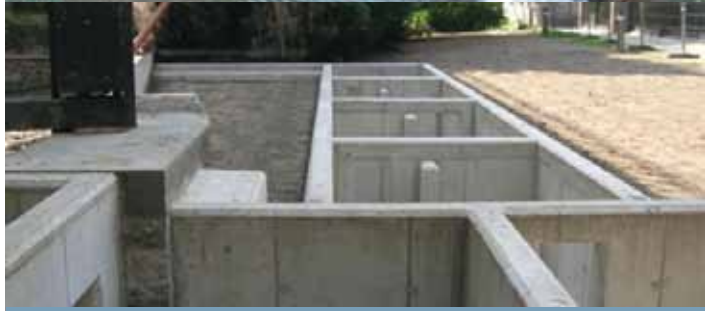
Passé à bassins en béton située derrière la salle communale du Maka à Yvoir. Une solution technique sophistiquée de contournement de l'obstacle a été trouvée pour s'adapter à l'aménagement d'une centrale hydro-électrique (vis hydrodynamique) sur un site exigu. La photo en haut de page illustre une vue globale du site aménagé avec la vis hydrodynamique et, en arrière-plan, la passe à poissons. L'autre photo représente une vue des bassins de cette passe en fin de réalisation
