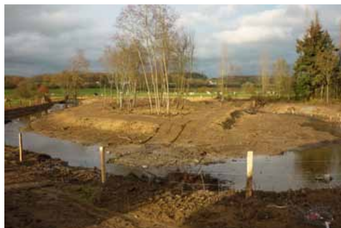
Réouverture d'un ancien méandre à Boussu-en-Fagne (Eau Blanche)
