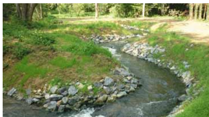
Rivière de contournement, permettant la remontée des poissons (le Bocq à Purnode)
