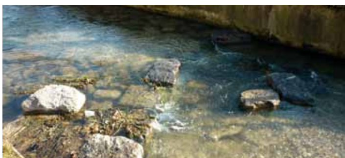
Rampe rugueuse établie dans un canal en béton à Spontin à proximité des captages de Vivaqua. L'aménagement consiste à augmenter la lame d'eau et à freiner sa vitesse par la rugosité des blocs rocheux et des galets et convertir ainsi le canal infranchissable en cours d'eau attractif pour les poissons
