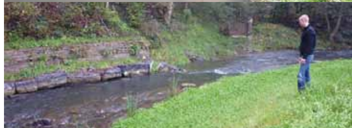
Effacement d'un barrage au village de Spontin : Le seuil a été démolit et le Bocq a retrouvé une vitesse de courant plus favorable pour la truite. La suppression du barrage permet également de rétablir le transit des sédiments de l'amont vers l'aval, indispensable par exemple pour la production de gravières. La photo en haut de page représente le site avant travaux et celle d'en dessous, le site après travaux
