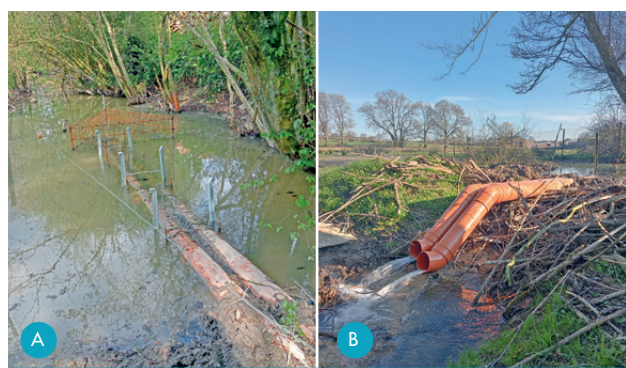
Vues du dispositif lors de son installation fin mars : en amont du barrage du castor avec le cube grillagé qui protège l'entrée du tuyau (A) et en aval avec une petite brèche faite au niveau du barrage pour y placer le tuyaux (B).
