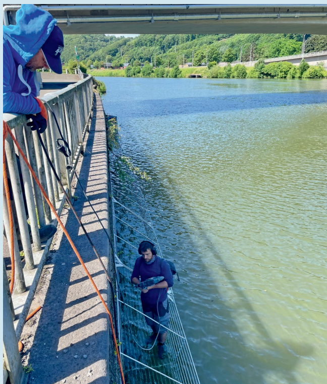
Installation de paniers végétalisés à Hastière.
