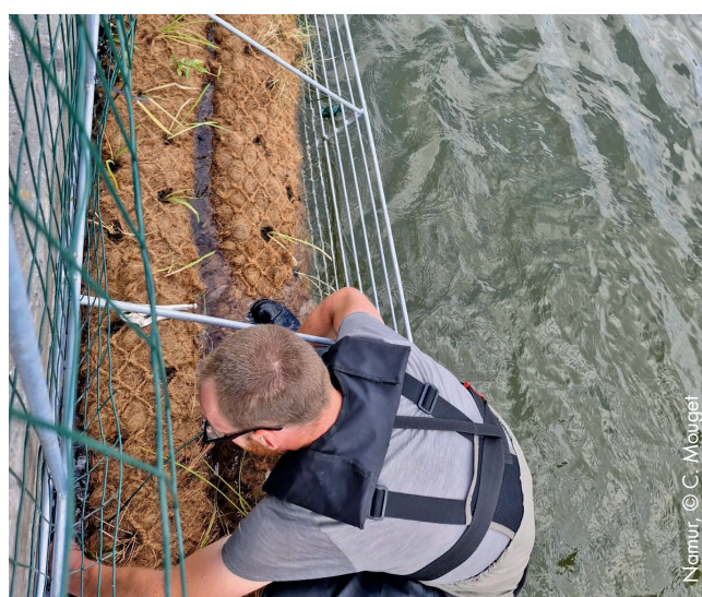
Plantation des végétaux semi-aquatiques dans les fascines en fibre de coco.
