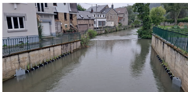
Deux fascines végétalisées de 5 m chacune ont été placées cet été le long des berges bétonnées du Bocq à Yvoir.
