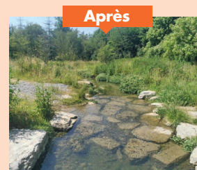
De gros blocs de pierres locales permettent un passage de charroi sans abîmer les berges restaurées
