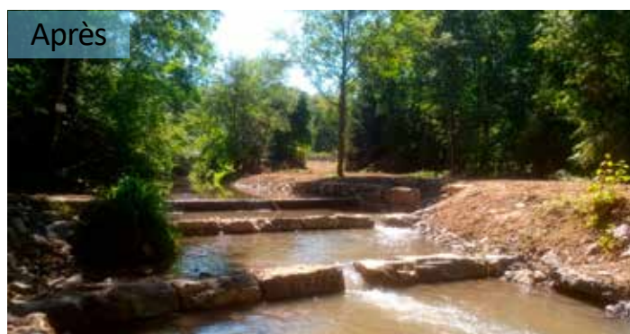
Obstacle à la libre circulation des poissons sur le Samson levé par le SPW – Direction des Cours d'Eau non navigables
