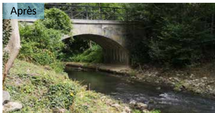
Pont restauré sur l'Eau Blanche par le gestionnaire de la voirie (SPW-Mobilité et Infrastructures)
