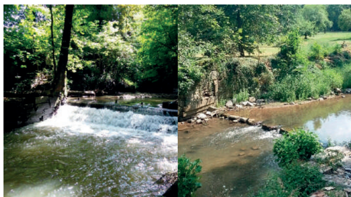
Juste avant la confluence du Samson avec la Meuse à Thon (Andenne), le SPW-DCENN a détruit un barrage en escaliers pour favoriser la libre circulation du poisson et des sédiments
