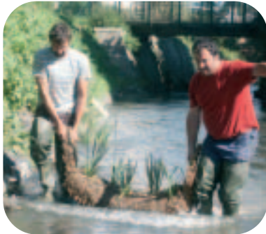
Utilisation de techniques végétales pour la réfection des berges.
