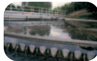
Bassin de décantation.
