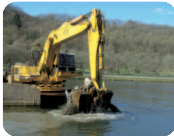
Travaux de dragage.
