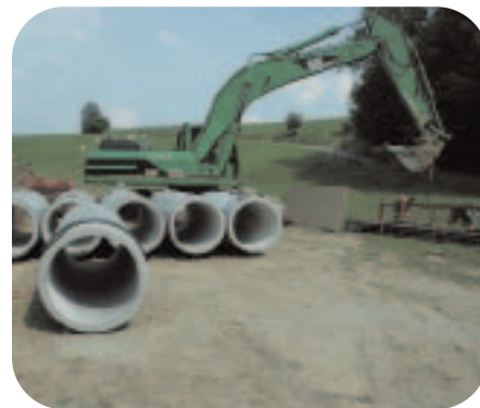
Pose d'un collecteur.
